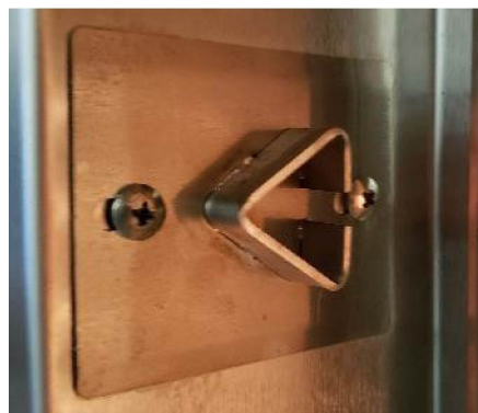
Rampe de verrouillage de la porte Fig. 51
